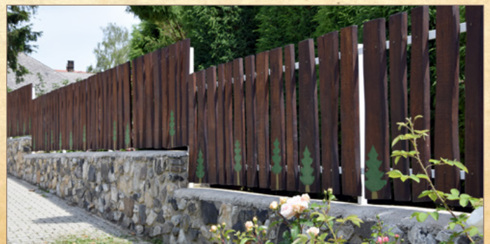
Az óvoda felújított kerítése
